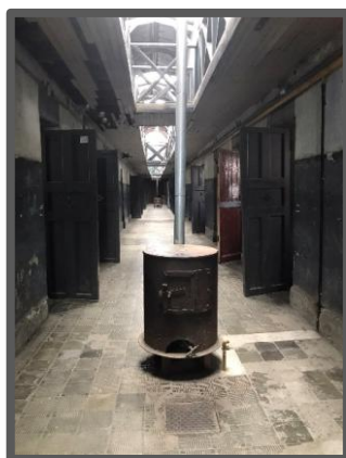
Couloir avec le poêle unique
